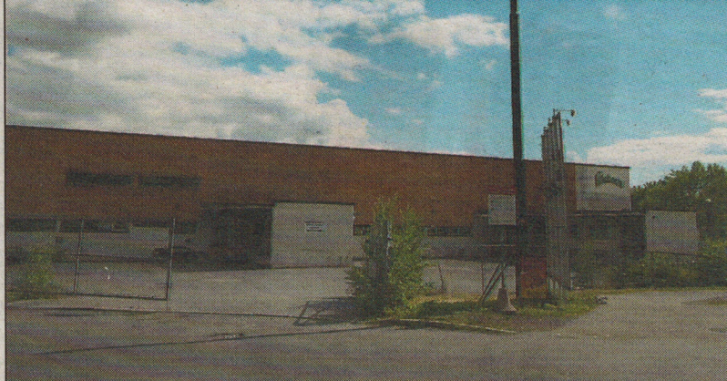
200 LEILIGHETER: Dette lageret skal rives og bli erstattet med blokker på inntil ti etasjer, hvis utbygger får det som han vil.
