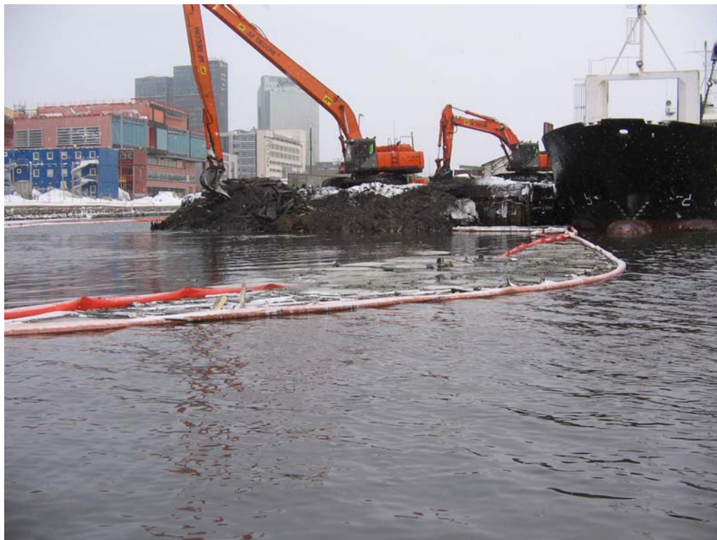
Figure 5. Siltgardin lagt ut ved oppgraving av Paulsenkaia. Akerselva i bakgrunnen (mars 2006).
